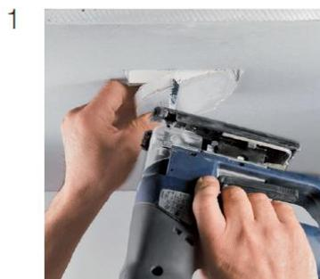
Effettuare il foro a misura nel soffitto di cartongesso.
